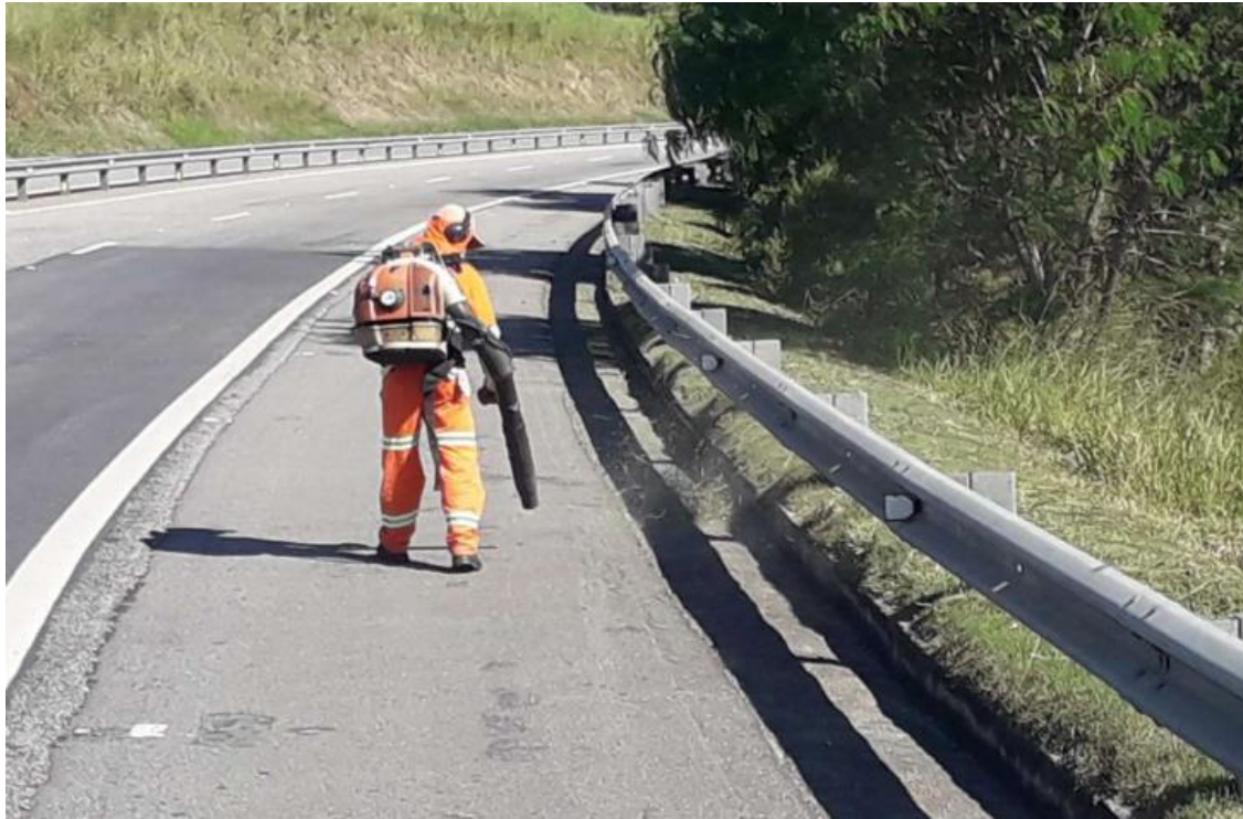
Figura 6.5 Via Lagos – Roçada Manual – Km 53+000 Norte
