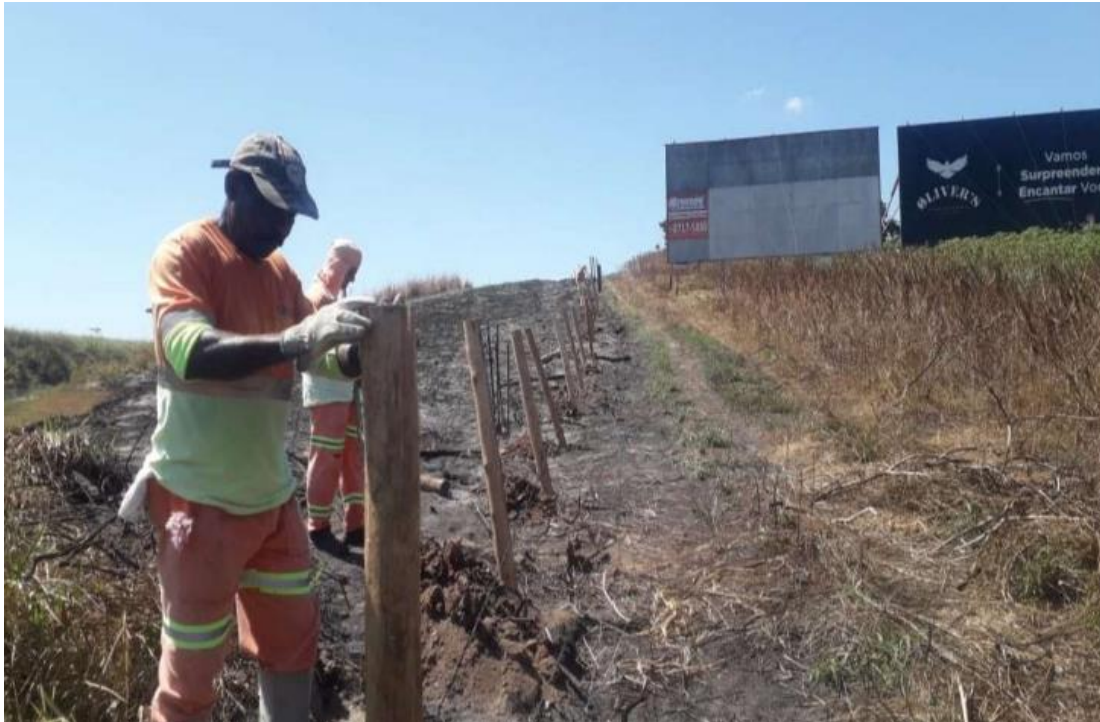
Figura 6.7 Via Lagos – Reparo de Cerca – Km 41+000 Norte
