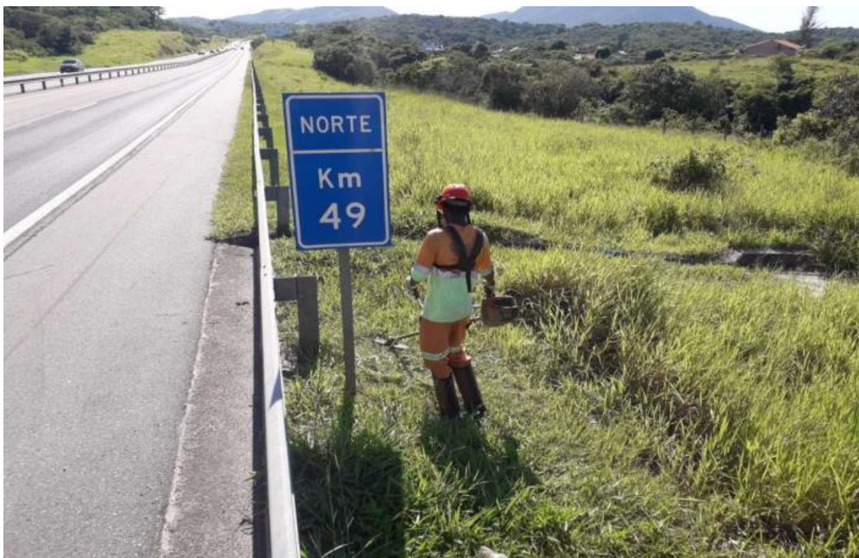
Figura 6.4 Via Lagos – Roçada Manual – Km 49+000 Norte
