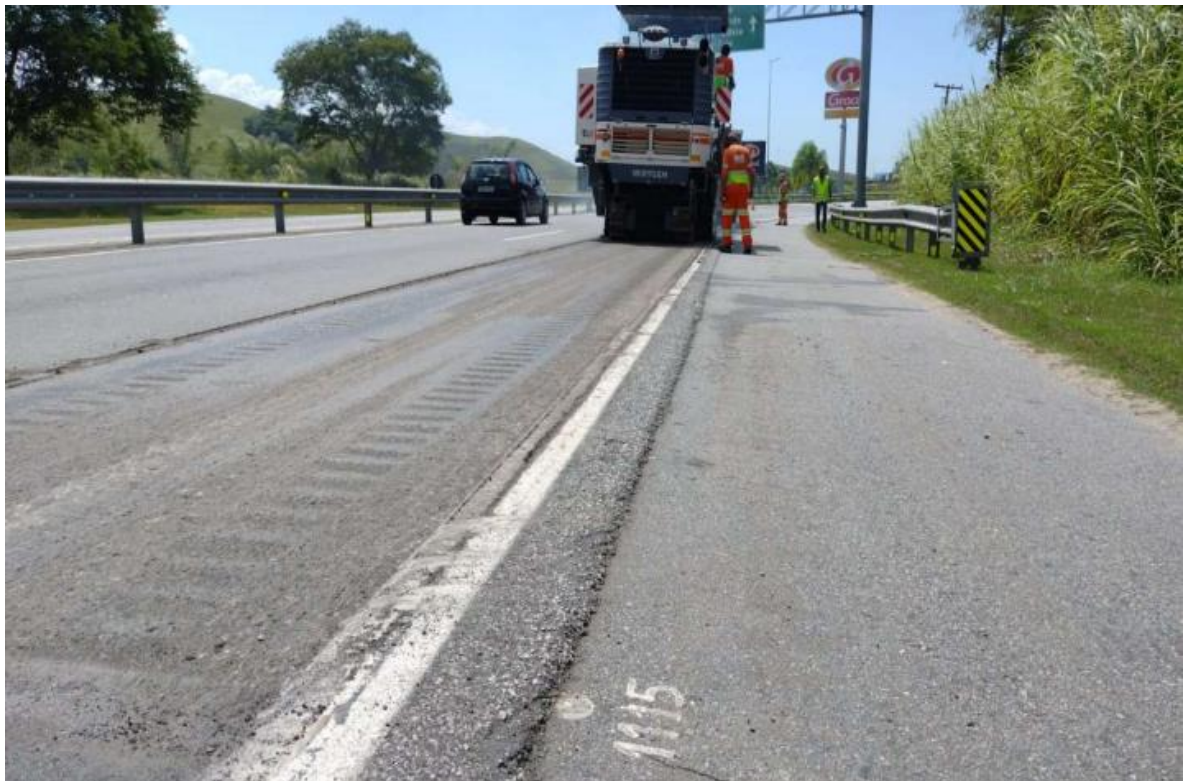
Figura 6.11 Via Lagos – Obra no Pavimento – Km 22+000 Norte
