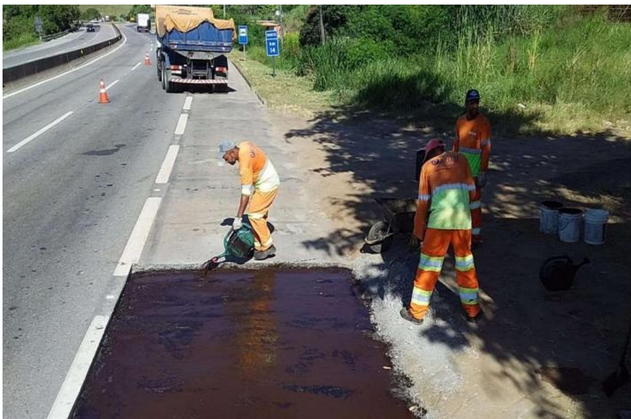
Figura 6.2 Via Lagos – Reparo Superficial de Acostamento – Km 14+000 Norte
