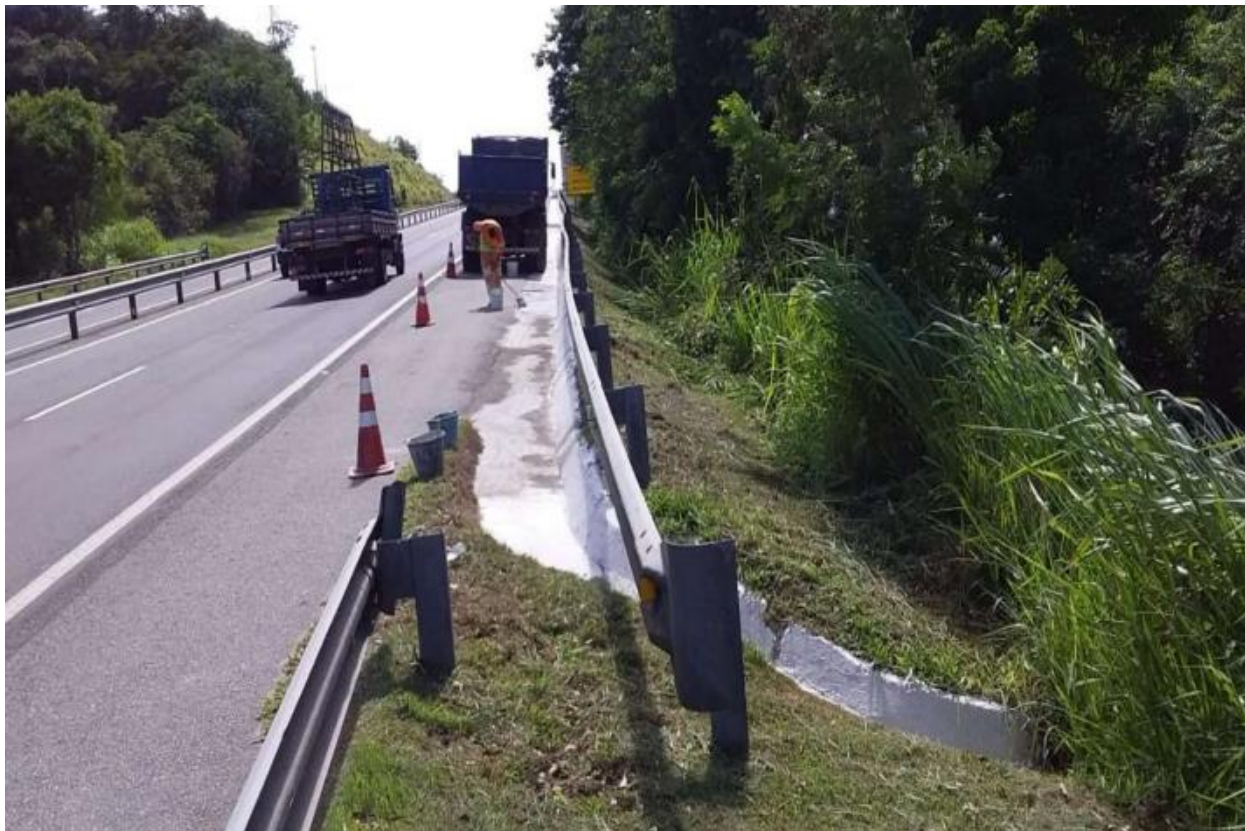
Figura 6.3 Via Lagos – Reparo de Sarjeta – Km 25+000 Sul
