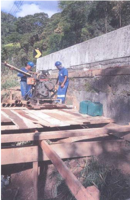
Figura 6.1725 Rota 116 – Reforço no Muro de Contenção – Km 56+600 Sul
