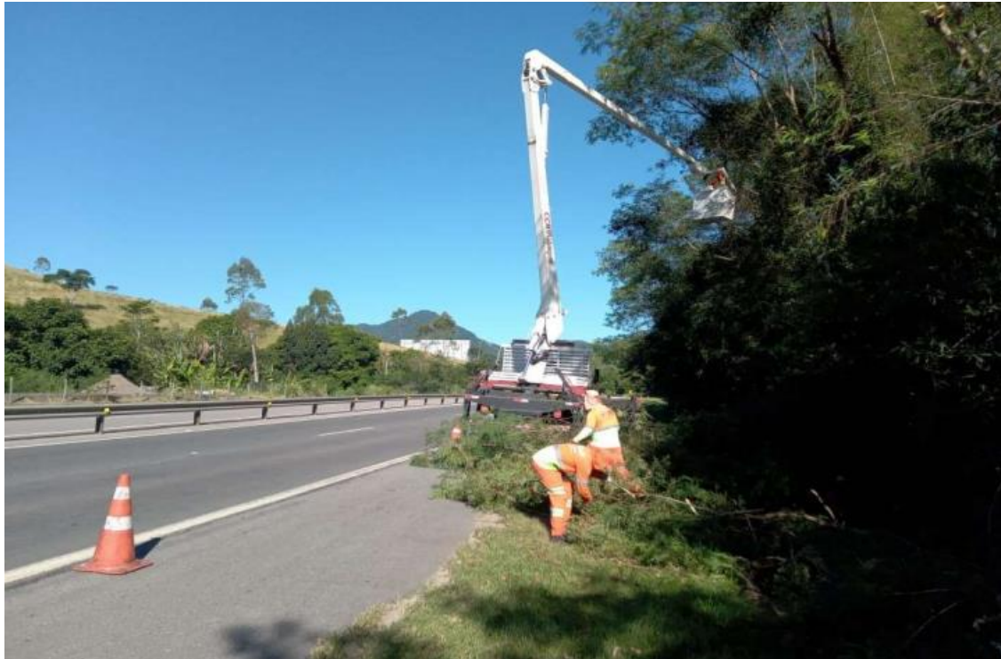
Figura 6.9 Via Lagos – Poda de Árvores – Km 19+000 Norte
