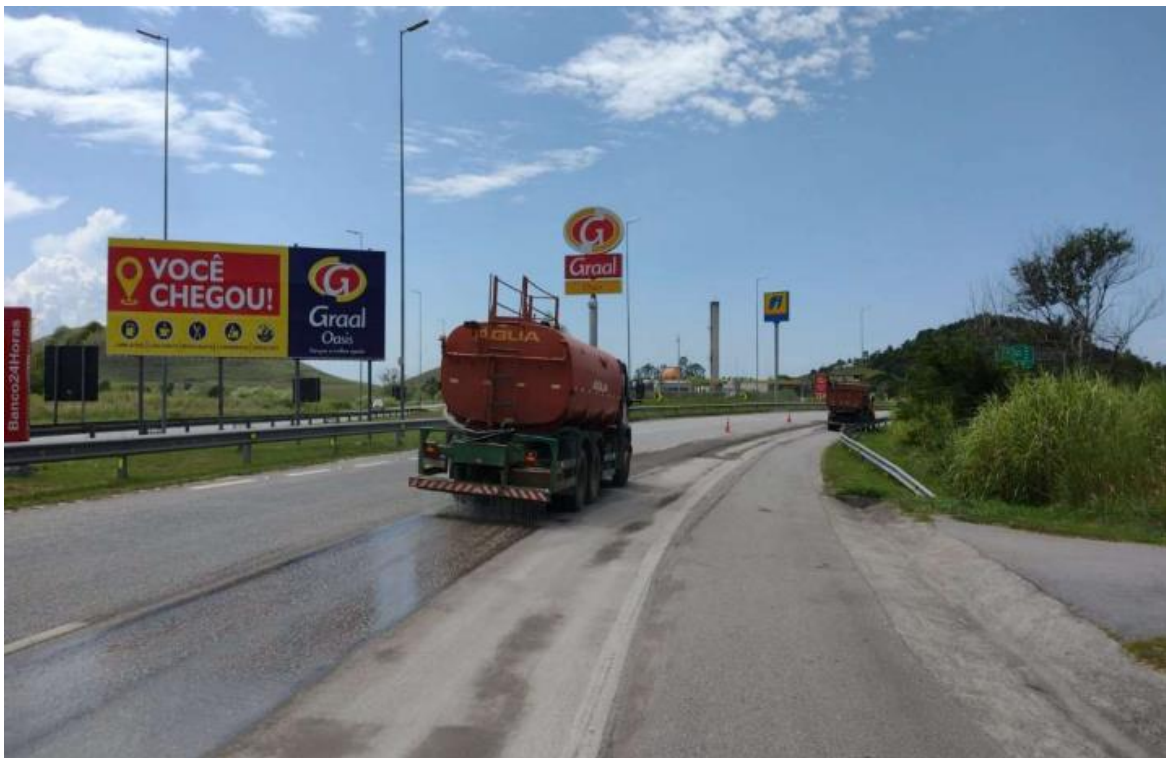
Figura 6.12 Via Lagos – Obra no Pavimento – Km 23+000 Norte
