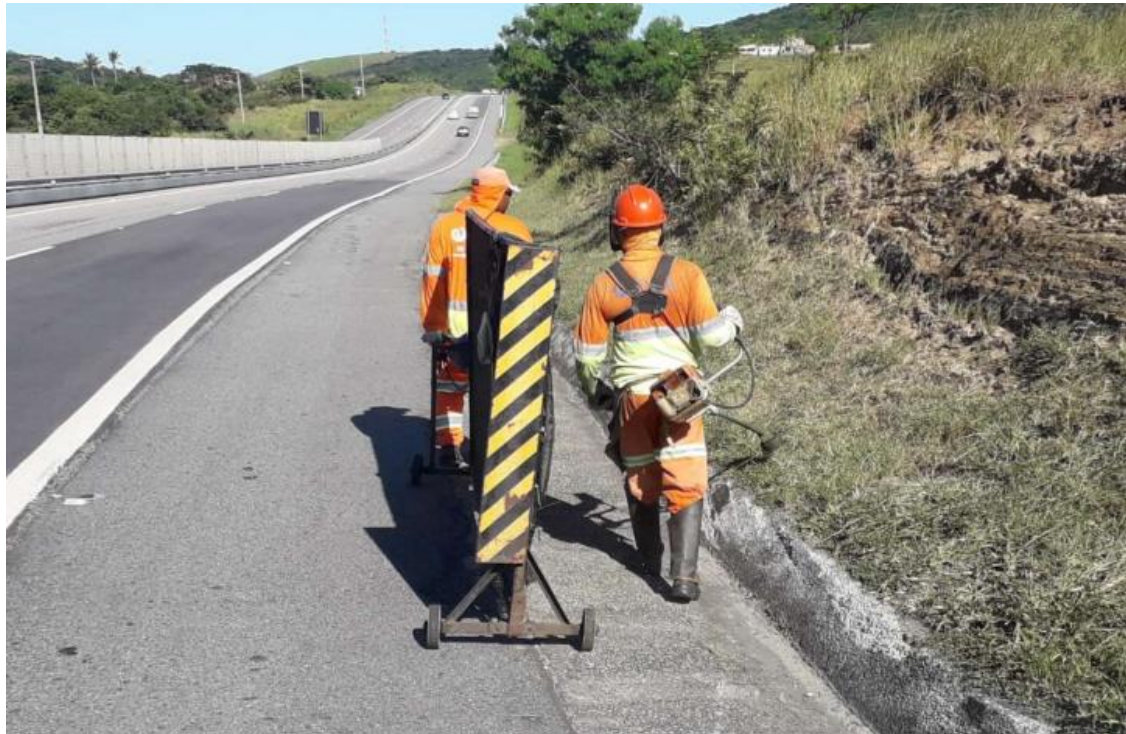
Figura 6.6 Via Lagos – Roçada Manual – Km 54+000 Norte
